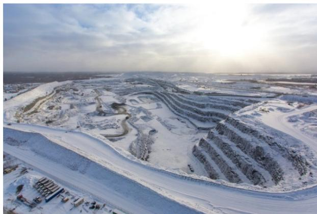
Pour ce qui est de sa profondeur maximale au terme de l'exploitation, la fosse Canadian Malartic projetée sera approximativement 35 m plus profonde que la fosse originale. Le niveau le plus bas prévu pour l'agrandissement de la fosse est de 90 m sous le niveau de la mer. La profondeur de la fosse finale sera d'environ 410 m par rapport au terrain environnant. L'accès au secteur de l'agrandissement Canadian Malartic se fera via une rampe d'une largeur de 35 m.
