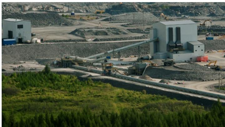
Un bâtiment, abritant les équipements et les accessoires, a été aménagé à cet effet. Le circuit de concassage secondaire permet d'optimiser l'étape de réduction du matériel; étape essentielle à la récupération de l'or.
