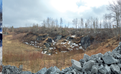
Barnat durant les travaux
