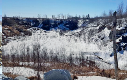
Barnat avant les travaux
